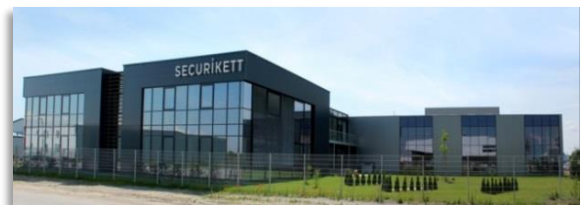
Unser modernes Headquarter und Produktionsgebäude in Münchendorf
