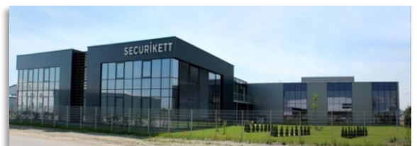
Unser modernes Headquartiers und Produktionsgebäude in Münchendorf
