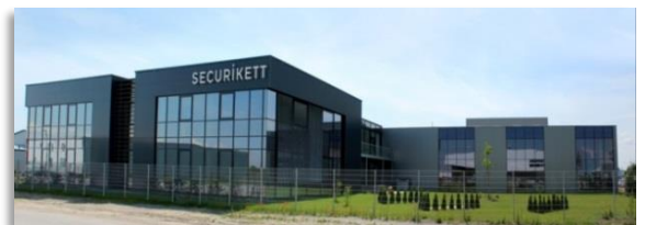
Unser modernes Headquarter und Produktionsgebäude in Münchendorf
